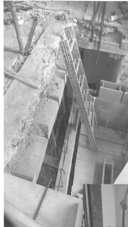
<< Herstellung des Liftschachtes (Foto: Elisabeth Putre)
