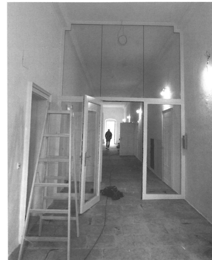
Brandabschnitts-Türen sorgen für Sicherheit in allen Stockwerken (Foto: Elisabeth Putre)
