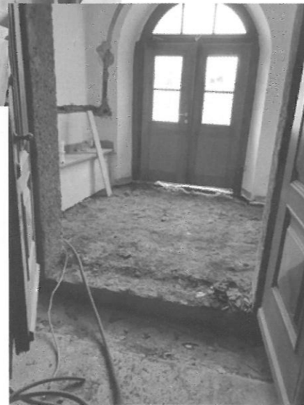
unten: Der Niveau-Unterschied am Haupteingang wurde behindertengerecht ausgeglichen (Foto: Mario Weiser)
